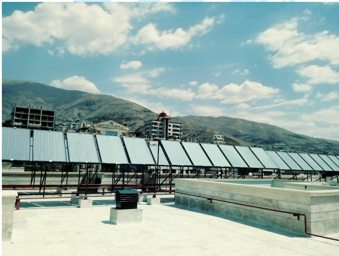
شکل ۶- قابلیت طراحی و اجرای سازه در ارتفاع بالاتر از سطح در فضاهای سایه انداز و دارای محدودیت نصب
