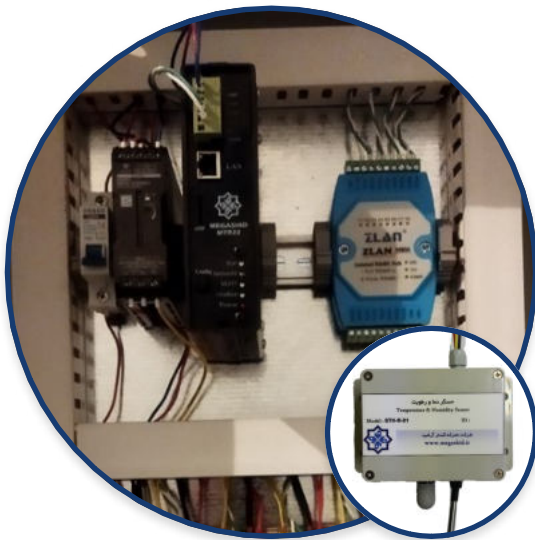
پایش شرایط محیطی توسط ماژول های حسگری و جمع آوری داده توسط ماژول RTU/Edge Controller
